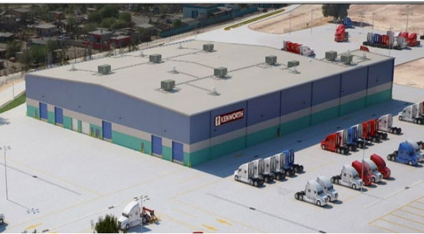
Edificio de Pruebas y Unidades Eléctricas
